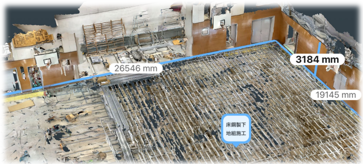
中学校体育館床改修工事 施工中
