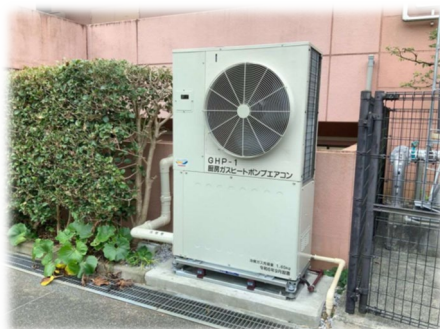
地域ケアプラザ空調機更新工事
