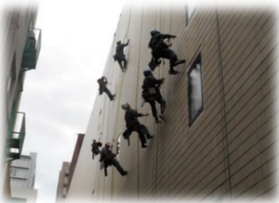
外壁点検(法定点検)
