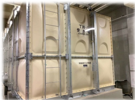
高等学校受水槽更新工事
