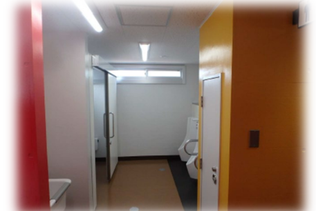
学校トイレドライ化改修工事
