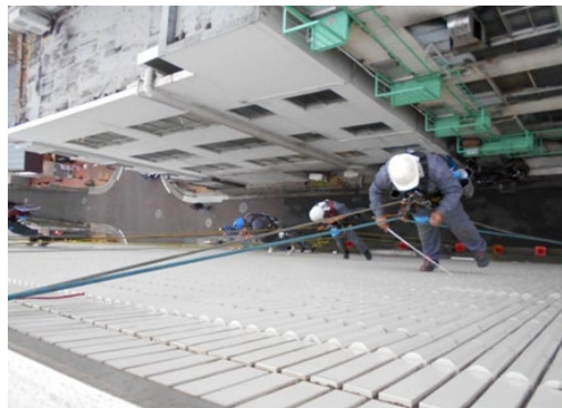
受託者による外壁詳細点検の様子
