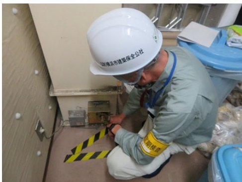
公社職員による建築設備点検の様子
