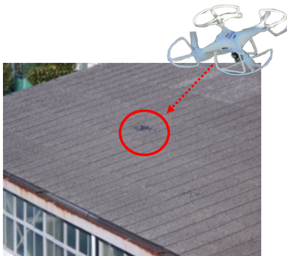
体育館屋根を調査中（写真中央にドローン）
