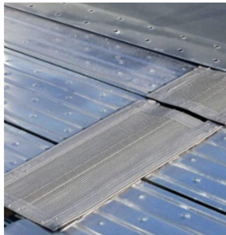
（床材間（横架材間）のすき間を埋める部材の例）
