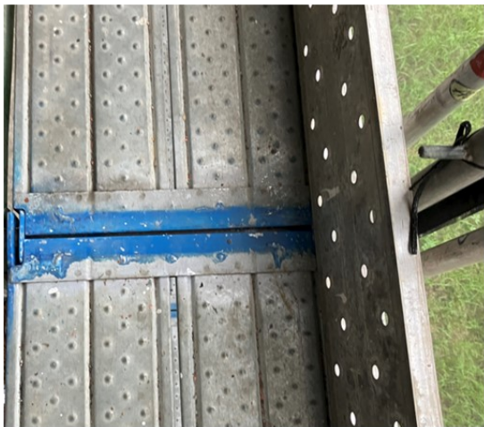
（床材間（横架材間）のすき間を埋める部材の例）
