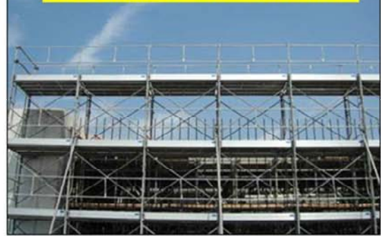
手すり据置き方式【ユニットタイプ】
