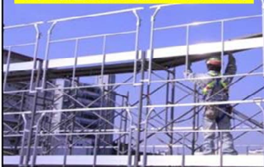
手すり据置き方式【幅木付手すりわく】
