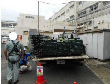
現場巡視(荷積状況確認)
