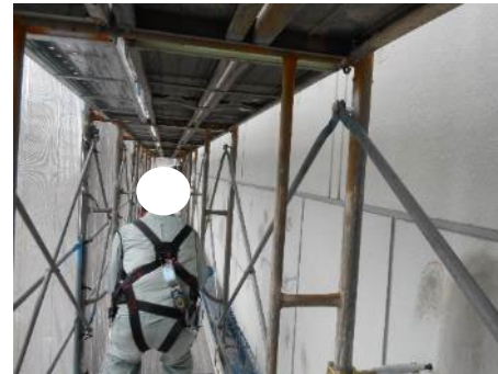
現場巡視(仮設足場内)
