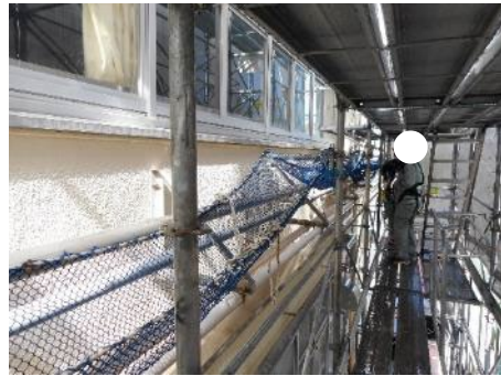
現場巡視(仮設足場内)
