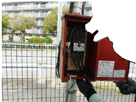
現場巡視(仮設電気)
