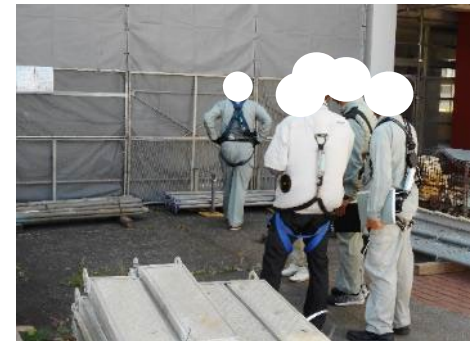
現場巡視(外周部)
